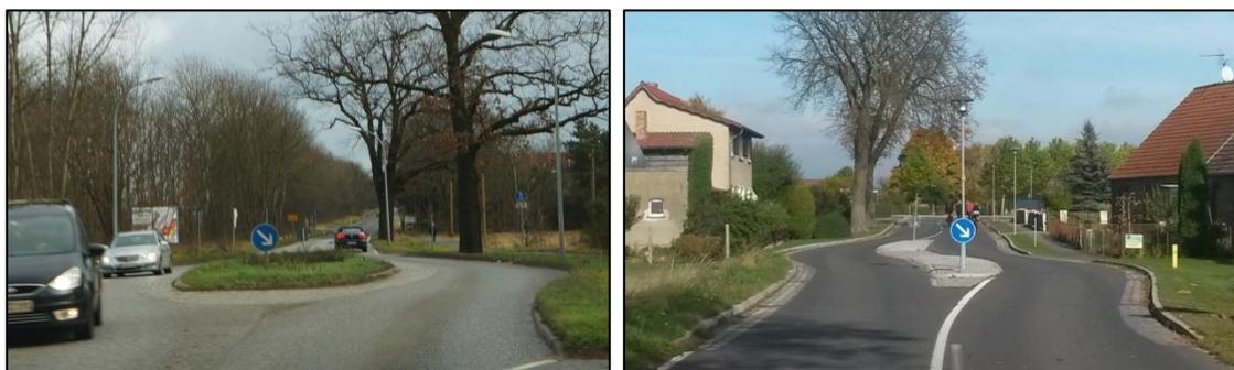
**Abb. 32** Beispiele Ortseingangsgestaltung mit Fahrstreifenversatz
