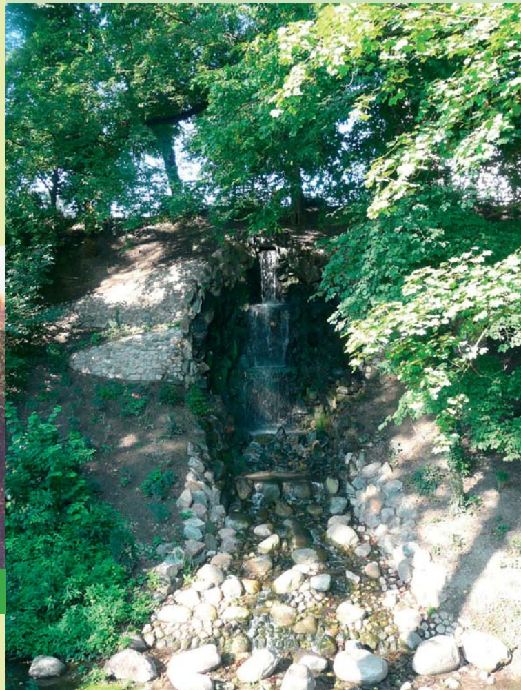
Die komplett erneuerte Kaskade Foto: P. Gudlowski
